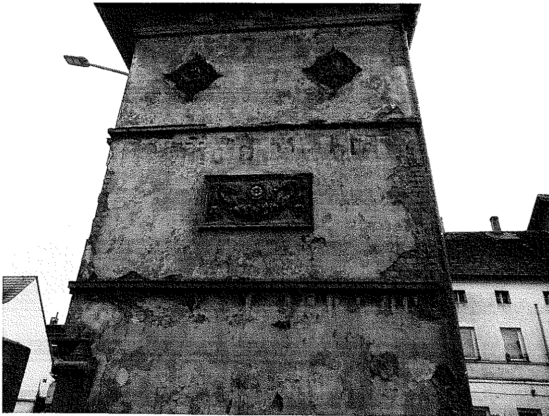
Zdjęcie nr 3 – Elewacja szczytowa
