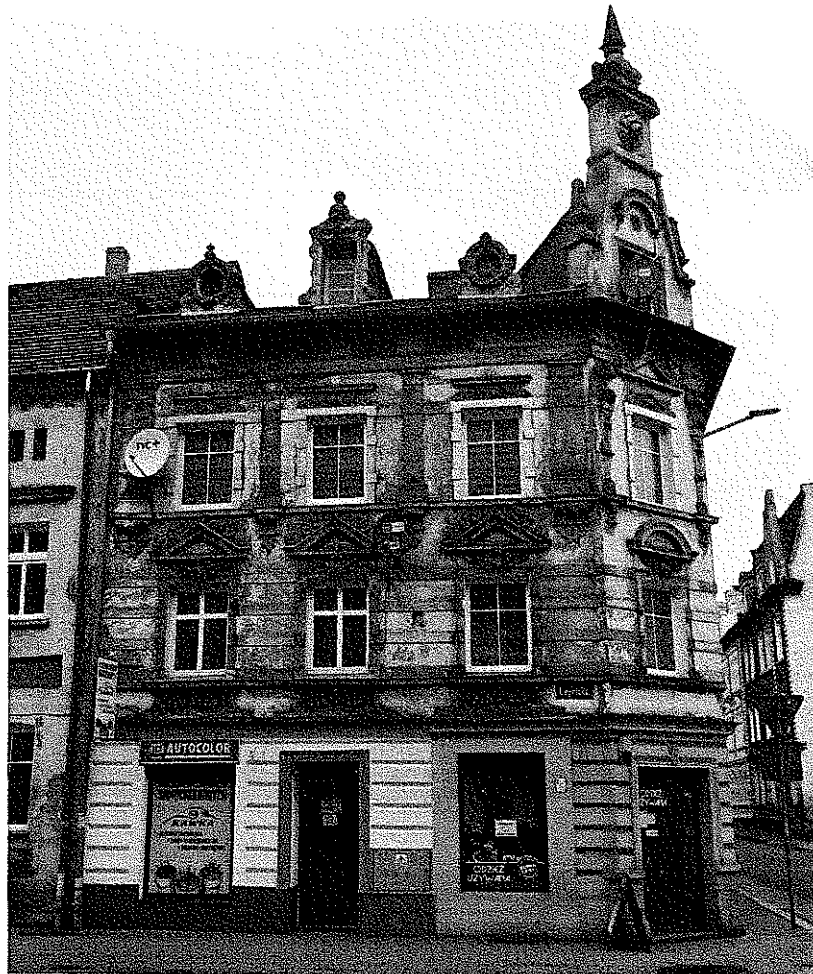
Zdjęcie nr 1 – Elewacja od strony ul. Legnickiej
