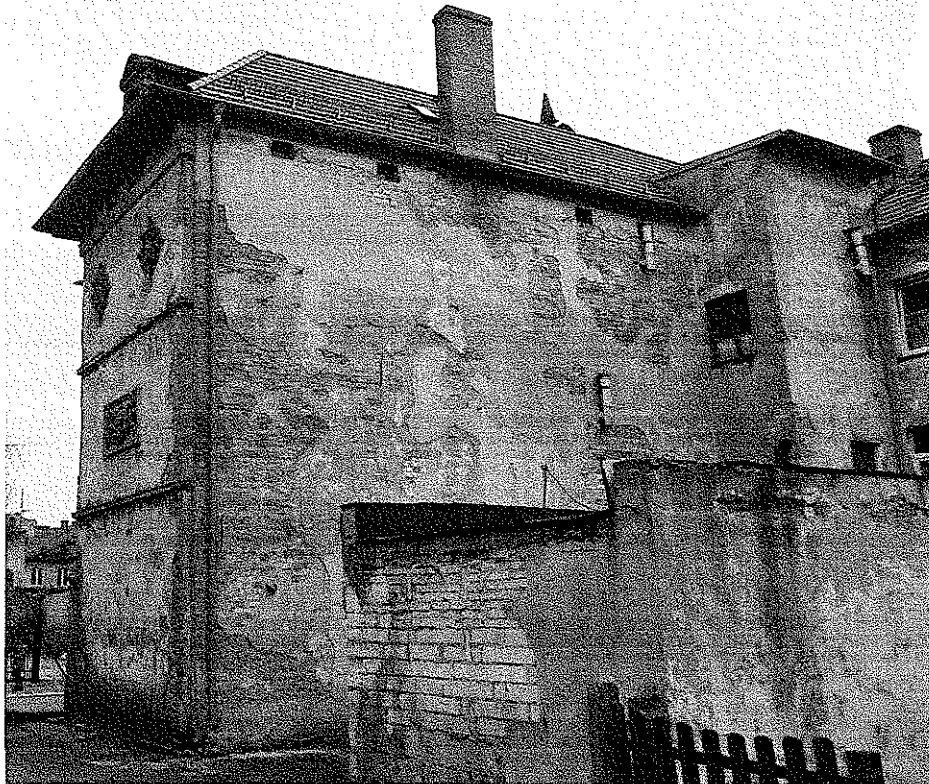
Zdjęcie nr 4 – Elewacja od strony podwórza
