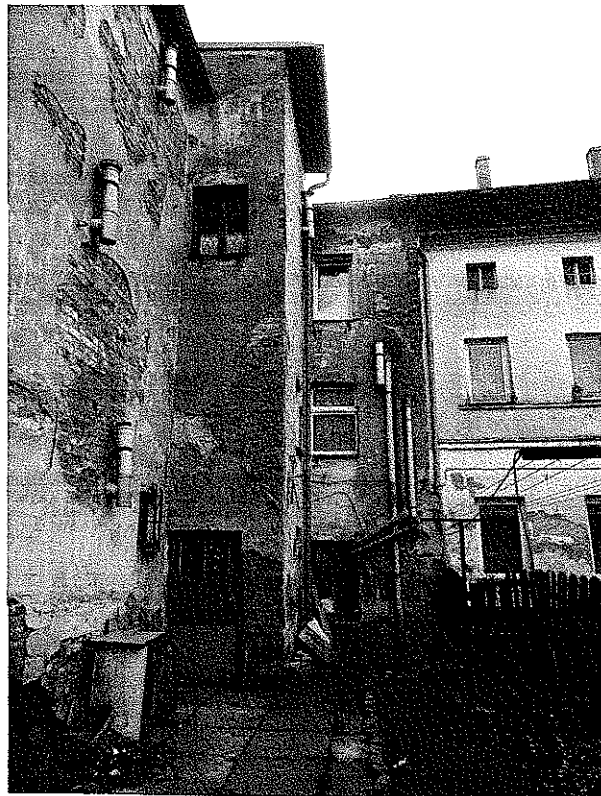
Zdjęcie nr 5 – Elewacja od strony podwórza
