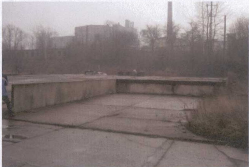
Fot.2 - Rampa na działce gruntu nr 22/74
