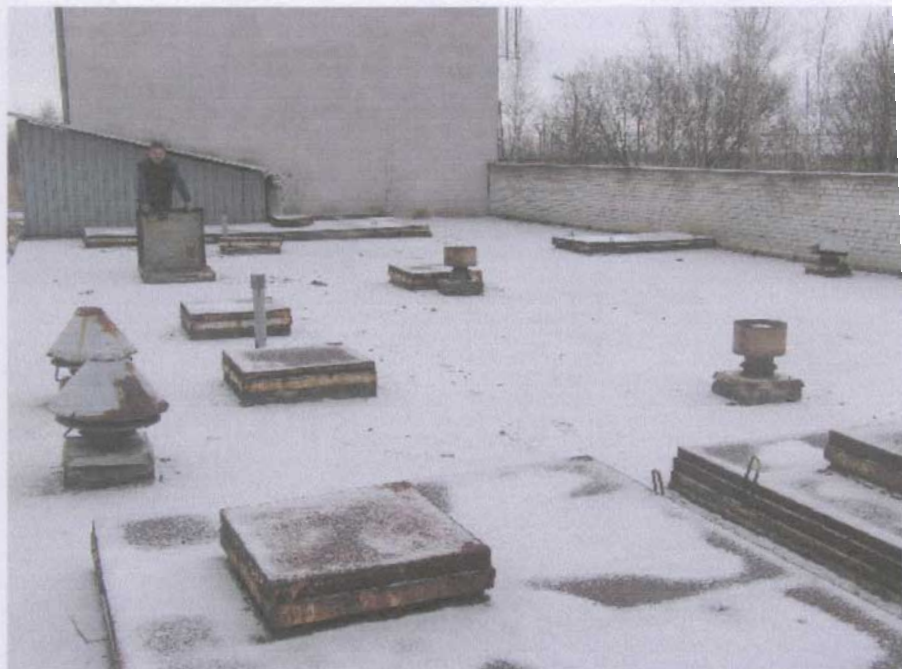
Podziemny magazyn północny
