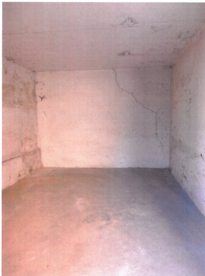
Widok wnętrza garażu na działce nr 46/12
